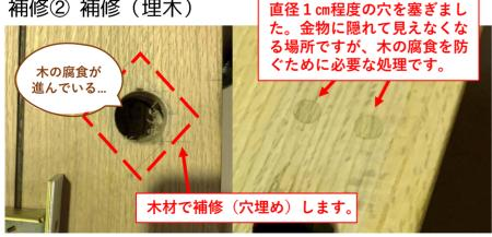
塗装剥離・研磨の後、ドアの補修を行いま す。今回は金物交換を行いますので、これ まで付いていたドアハンドルや鍵の加工穴 の中で不要になる穴を塞ぎます。この作業 は美観の維持だけでなく、不要に空いた穴 <u>から木の腐食が進むのを防ぎます。</u>補修完 了後、新しい金物用の穴加工を行い、最後 に再塗装をして工場作業完了です。
