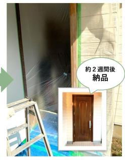
再びご自宅にお伺いし、ドアの 「枠」の再塗装を行います。枠も ドアと同様に塗装剥離を行い、表 面を整えてから再塗装を行います。
